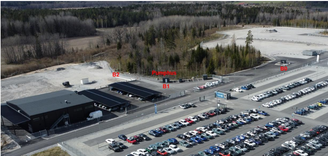
Figur 6-1. Översiktbild mot nordväst som visar de tre bergbrunnarnas placering, B0, B1 och B2.
