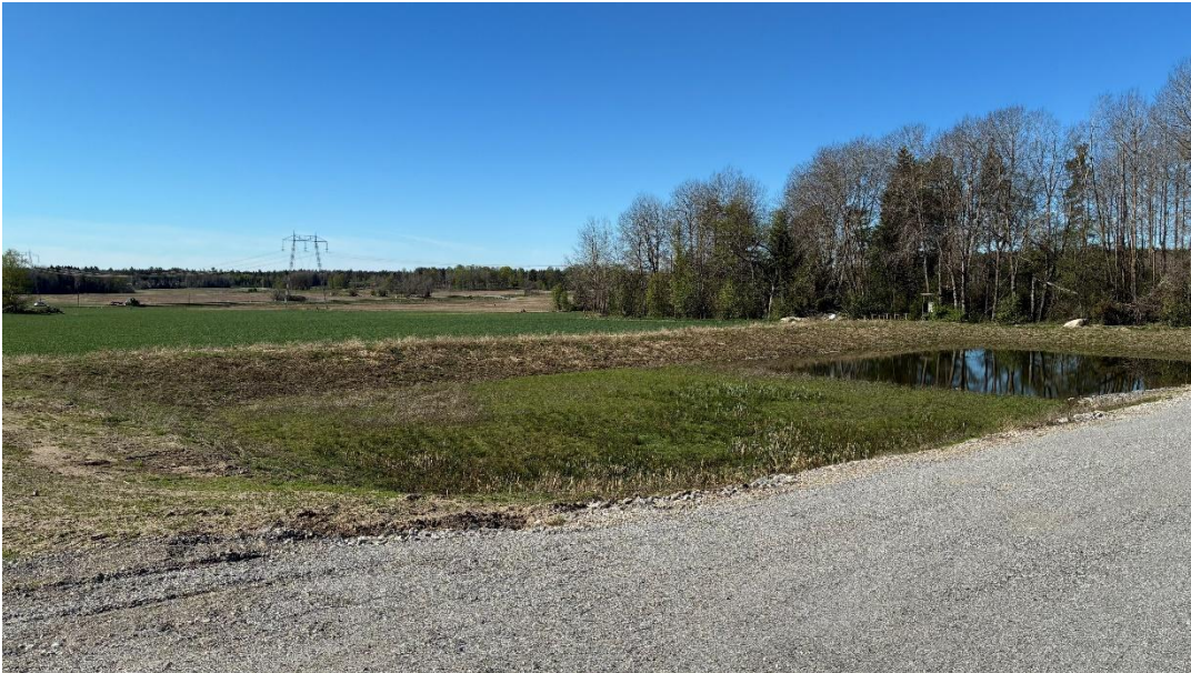
Figur 8-5. Dagvatten leds till ett dike beläget direkt söder om Lunda företagspark. Vatten rinner därifrån efter fördröjning vidare i ett öppet dike som finns nära kraftledningen och vidare under väg 273 ner mot skogsområdet som syns längst ner i bilden.
